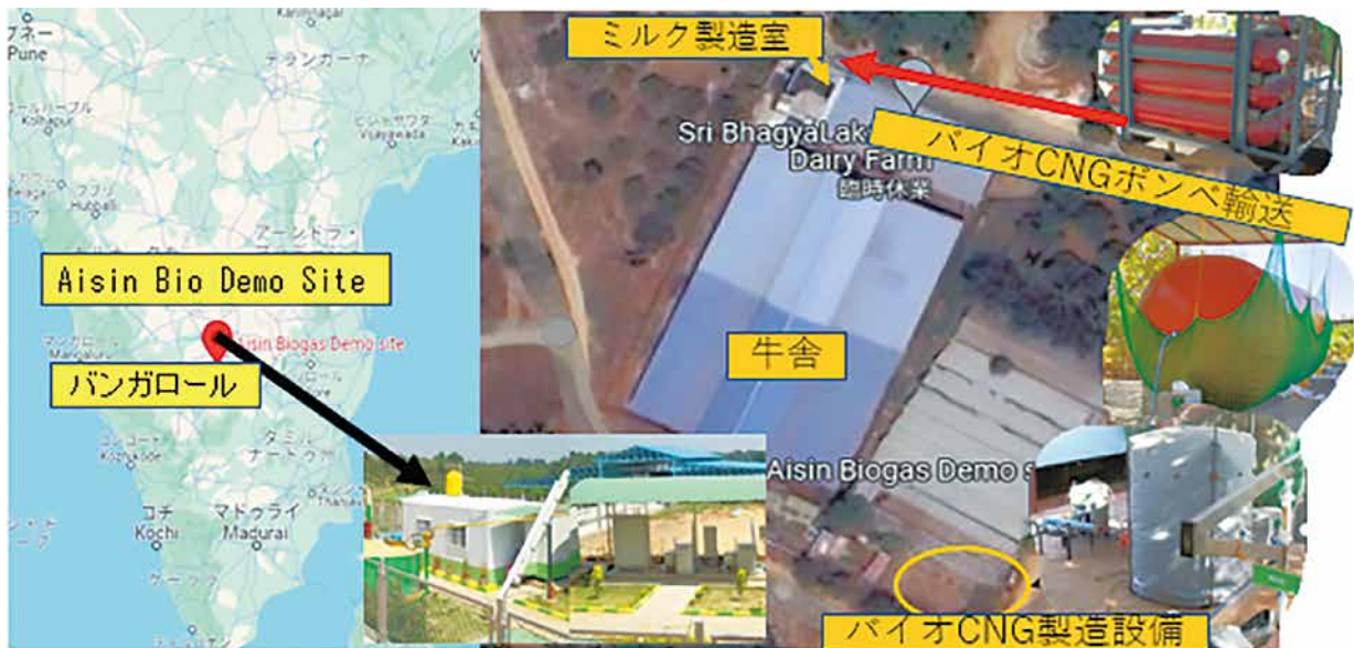
図1 バイオメタン製造システム設置サイト
